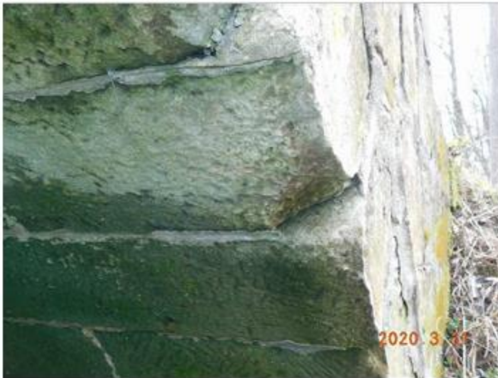
Uražená hrana kamene, chybějící spárování.
