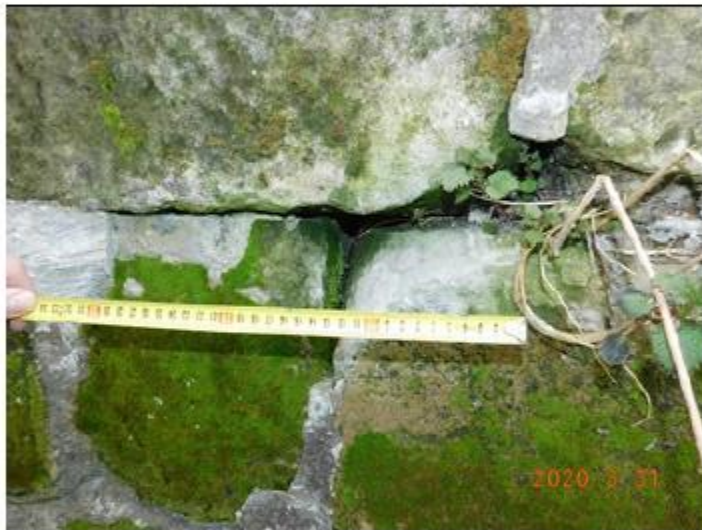
Hlubková degradace spárování křídla.
