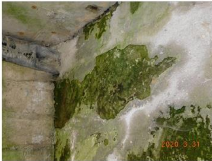
Plošná separace omítky čelní zdi klenby na levé straně.
