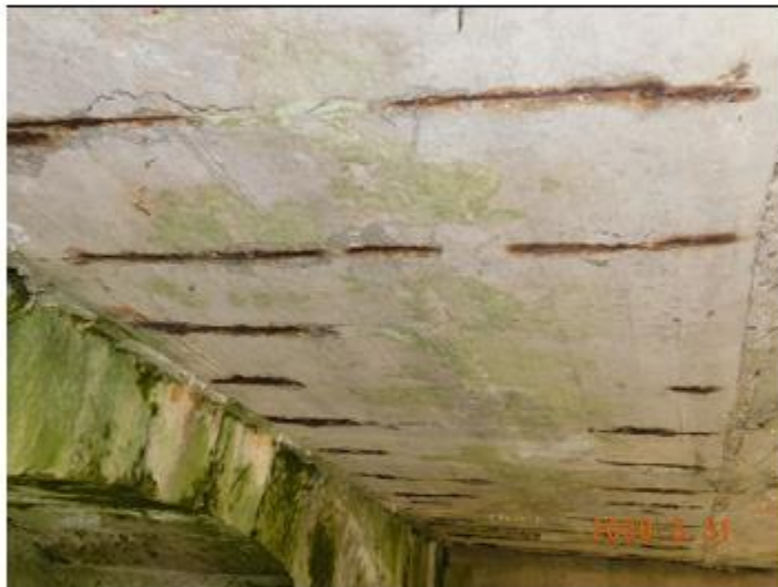
Plošně prokreslená korodující výztuž na spodním lici nosné konstrukce nosníků ŽMP, stopy po zatékání.
