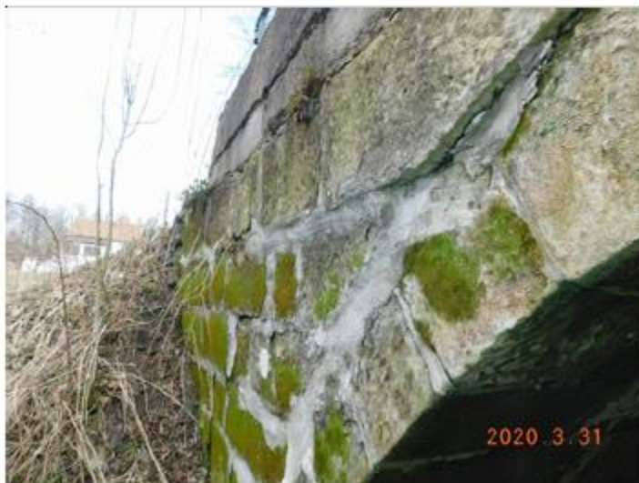
Vysunuté kamenné bloky pravého křídla u opěry OP1.
