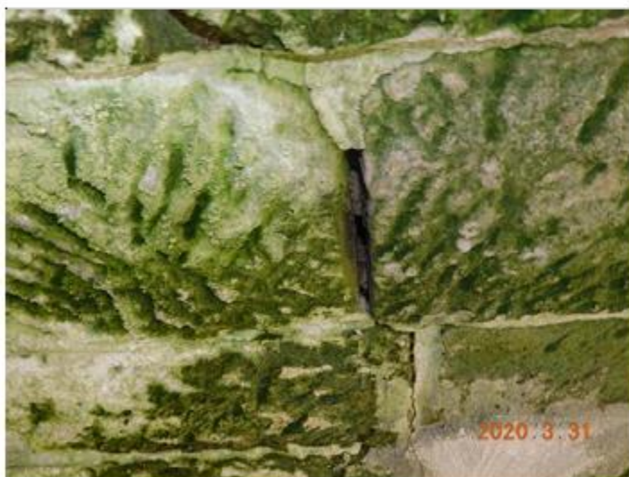
Podélná trhлина v klenbě na pravé straně nosné konstrukce.
